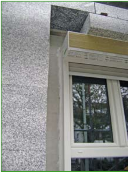
FeBa Rollladen-Neubaukasten als „Linksroller“ komplett im Dämmbereich der Außenfassade integriert
