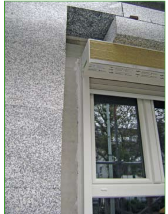
FeBa Rollladen-Neubaukasten als „Linksroller“ komplett im Dämmbereich der Außenfassade integriert
