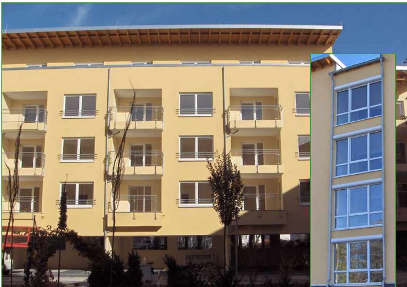
Das umfassende Koordinations- und Ausführungsmanagement steht auch in der Montagephase (Realisierungsphase) im ständigen Dialog mit dem Auftraggeber. So entstehen Systemlösungen, optimal auf die bauphysikalischen Anforderungen zugeschnitten.
