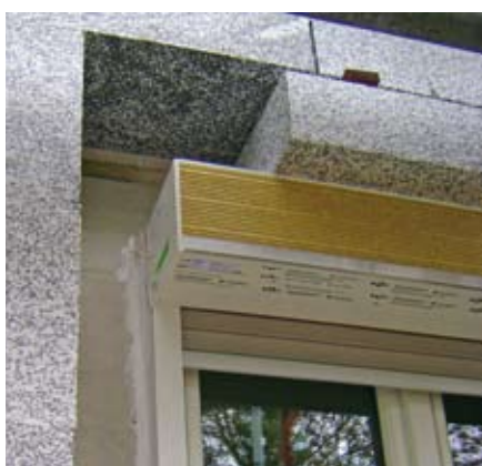
FeBa Rollladen-Neubaukasten als „Linksroller“ komplett im Dämmbereich der Außenfassade integriert.
